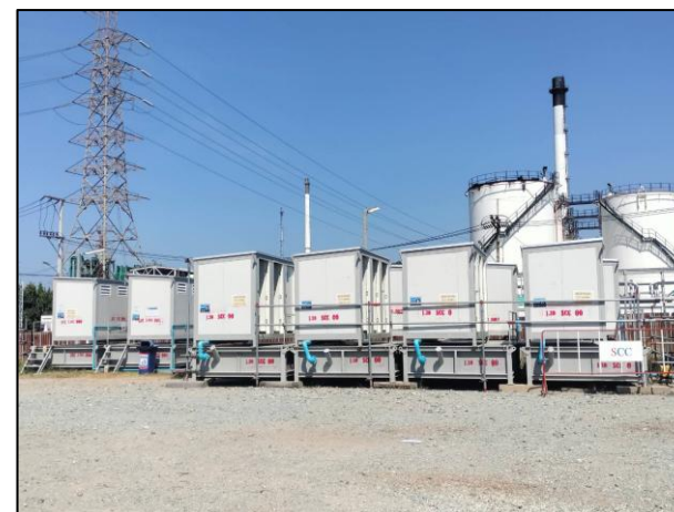
รูปที่ 2-7 ห้องน้ำ ห้องส้วม พร้อมระบบบำบัดน้ำเสียสำเร็จรูปแบบเคลื่อนที่
