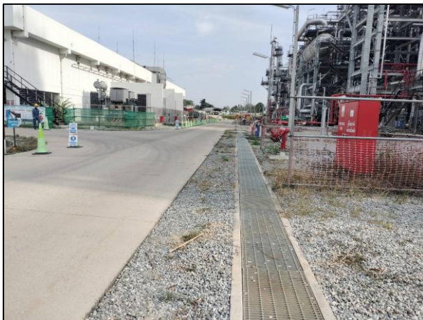
รูปที่ 2-8 ระบบระบายน้ำในพื้นที่ก่อสร้างและเชื่อมต่อกับบ่อรวบรวม
