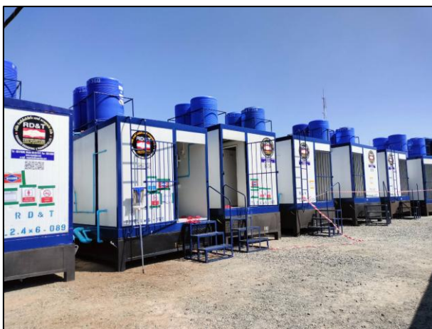
รูปที่ 2-7 ห้องน้ำ ห้องส้วม พร้อมระบบบำบัดน้ำเสียสำเร็จรูปแบบเคลื่อนที่
